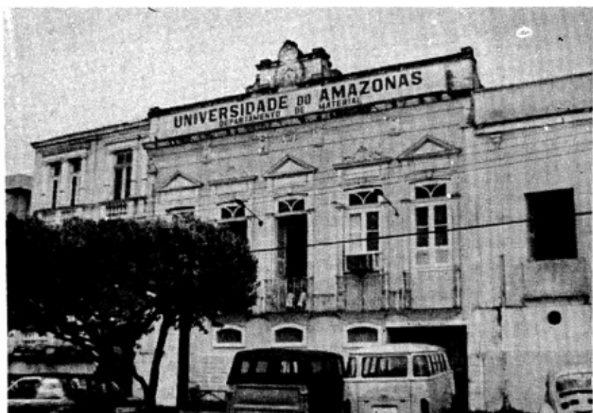
O edifício que fora a segunda sede do Ideal Clube, em 1906. Sito a Rua Simão Bolívar (Praça da Saudade), tem hoje o n.º 215 e é propriedade da Universidade do Amazonas. Conserva, ainda, na fachada os mesmos detalhes arquitetônicos de seus primórdios (exceto a mutilação com a abertura de uma entrada para veículos, no porão).
